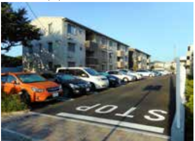
建設中の旧自由広場 2016/8/25
